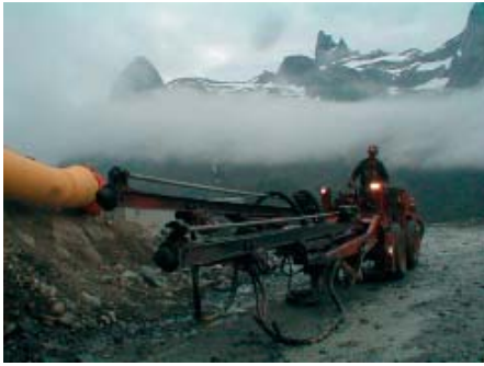
Ved brydning af tunnellerne benyttes en Jumbo. To arme med diamantborehoveder kan manøvreres hver for sig. I dag er alle minekøretøjer forsynet med fjærrhus.
