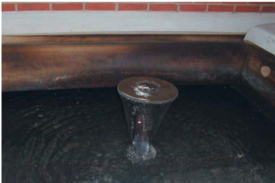
Ilttingsanlæg på vandværk. (Foto: Dansk Geofysik)
