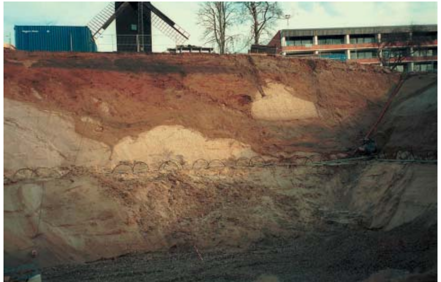
Foto af sandlagserien og den øverste till i retning mod SSØ. Store partier af smeltevandsmaterialer er oparbejdet i den øverste till tillige med store linser af fedt, tertiært ler samt linser af den nederste mørke till. Sugespidserne midt i billedet holder udgravningen tør. (Foto: Forfatteren)
