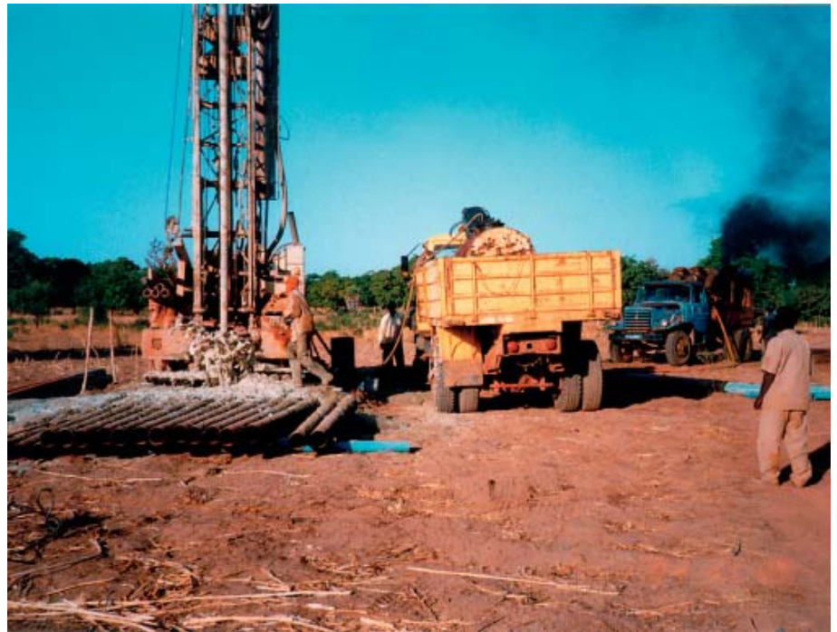
Udførelse af boring i grundfjeld. Boreriggen til venstre i billedet er ved at bore igennem forvitningszonen. Kompressoren på lastbilen i baggrunden arbejder hårdt. (Foto: Forfatteren)
