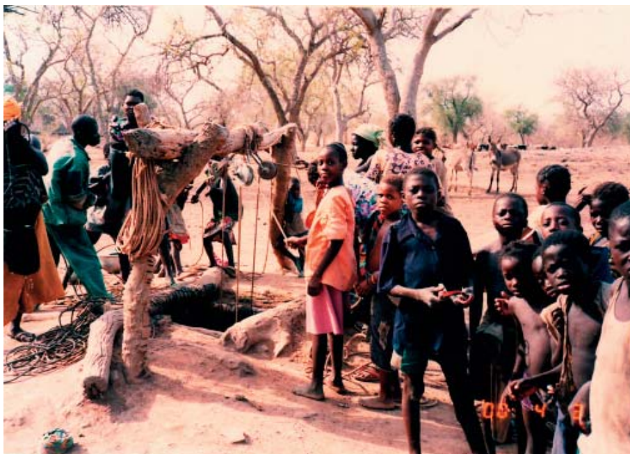
Traditionel brønd, der kun er støttet i overfladen af nogle kævler. Brønden, som findes i den sedimentære zone, er omkring 50 m dyb. De lange tove ved siden af brønden viser den store dybde til vandspejlet. (Foto: Forfatteren)
