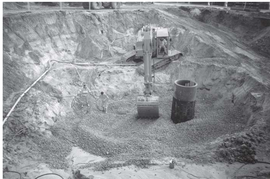
Etablering af et stenlag, en faskine, over det forurenede lerlag. (Foto: Henrik Kjør Nielsen)
