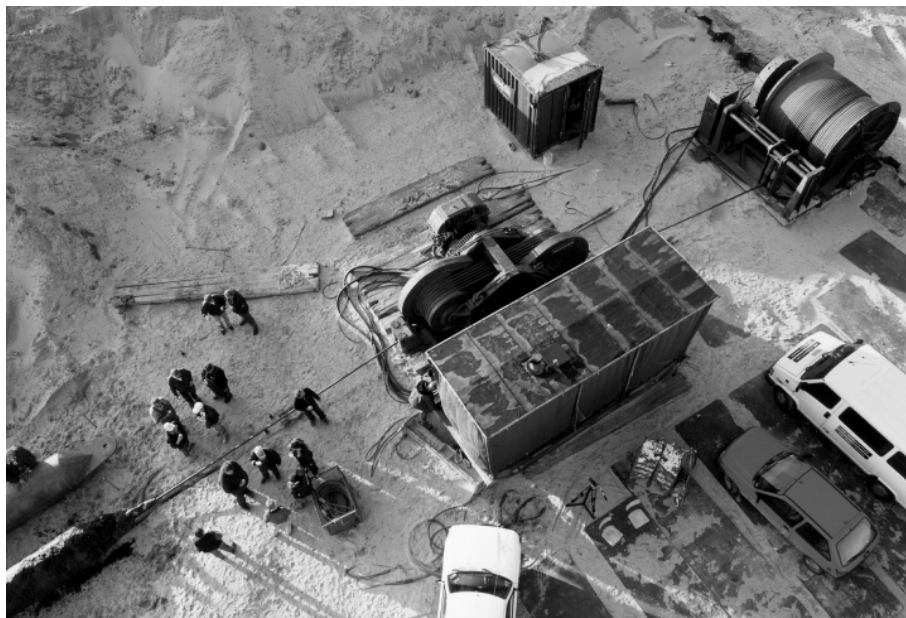
Her kommer den sidste fjernvarmeledning i land trukket af et spil. (Foto: Per Aarsleff A/S)
