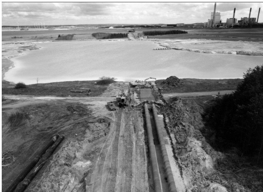
Linieføringen set fra syd med rørgrav, sø, Limfjord og Vendsysselværket. (Foto: Per Aarsleff A/S)
