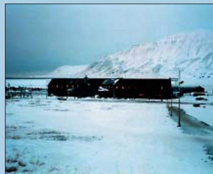
UNIS-bygning i Longyearbyen på Svalbard. (Foto: Forfatteren)
